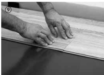
9 Anschließend wird das Element stirnseitig abgesenkt. Beachten Sie hierbei, dass das Element stirnseitig bündig an das zuvor verlegte Element anstößt. Durch kurzen Druck auf den Querstoß rastet das Element ein.
