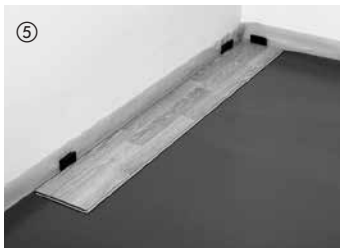
5 In der rechten Raumecke beginnend, werden die Elemente mit der Federseite zur Wand verlegt und mit Abstandskeilen fixiert (Dehnungsabstand zur Wand 10–15 mm).
