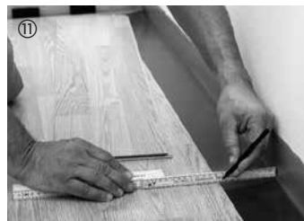
11 Die Elemente der letzten Reihe werden an der Längsseite unter Berücksichtigung eines Dehnungsabstandes von 10–15 mm zugeschnitten und eingepasst.
