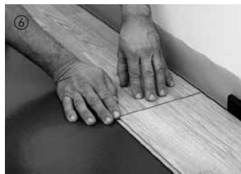
6 Die weiteren Elemente der ersten Reihe sind an den Kopfenden einzuklicken. Durch kurzen Druck auf den Querstoß rastet das Element im angrenzenden Element ein. Hierbei ist auf eine exakte Flucht der Elemente zu achten. Das letzte Element der ersten Reihe wird unter Berücksichtigung des Dehnungsabstandes von 10–15 mm zur Wand zugeschnitten und eingefügt.
