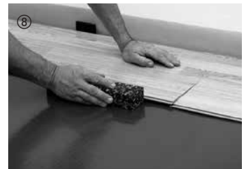
8 Bei Bedarf mit Schlagklotz leicht nachklopfen.
