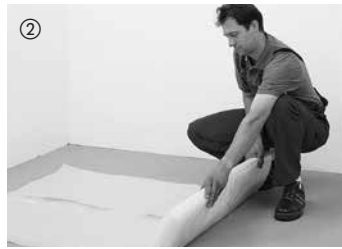
2 Grundsätzlich ist bei allen Estrichen und bei Verlegung auf Fußbodenheizung eine 0,2 mm starke PE-Folie auszulegen. Diese soll im Stoßbereich 30 cm überlappen. Anschließend die Folie im Wandbereich hochziehen und nach der Sockelleistenmontage an der Oberkante abtrennen.
